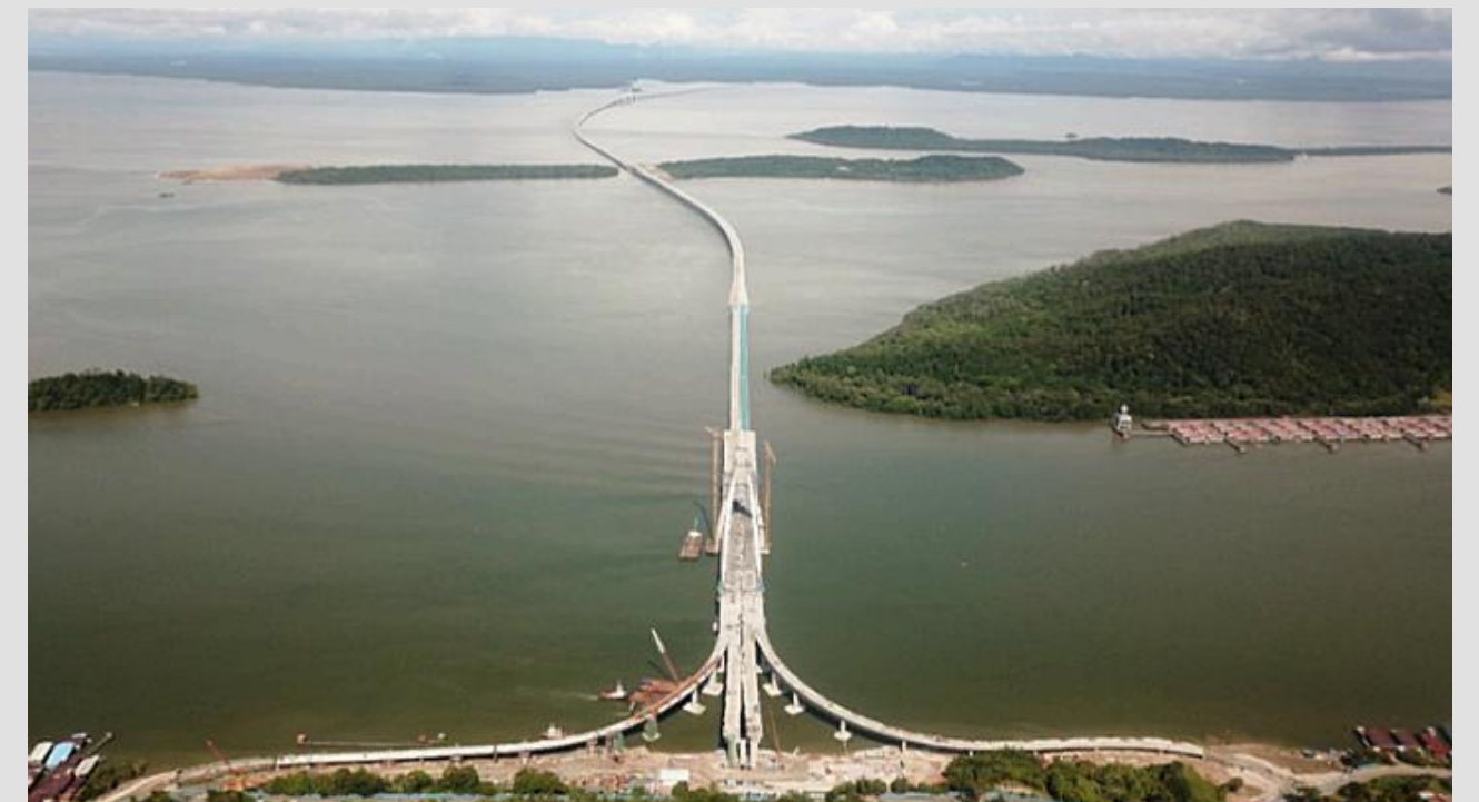
Puente de Temburong · Brunéi
